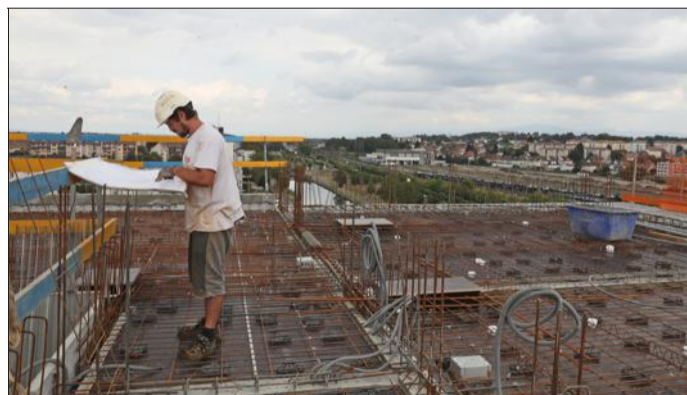
Une vingtaine de corps d'état interviennent actuellement sur le chantier. L'ensemble du gros œuvre doit être terminé d'ici fin 2018. Livraison finale du bâtiment : fin 2019. Photo L'Alsace
