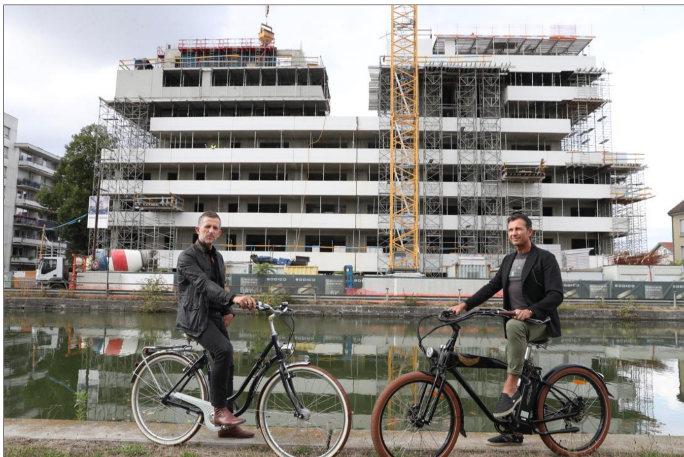
Marc et Claude Di Giuseppantonio, devant le chantier de l'Almaleggo, jeudi dernier. Le tronçon du quai de l'Alma situé entre la nouvelle tour et le canal du Rhône au Rhin sera à terme réduit à une simple piste cyclable bidirectionnelle. Photos L'Alsace/Darek Szuster
