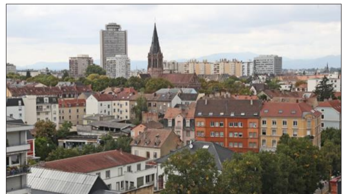
Le chantier n'en est qu'au huitième étage, mais la vue sur les alentours est déjà sympathique. Une fois achevé, l'Almaleggo comptera 12 étages. Photo L'Alsace
